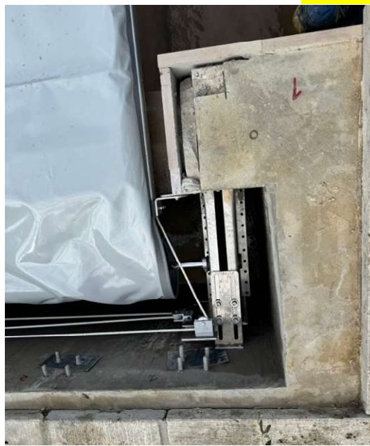
INSTALLAZIONE INFINITY SU LATO DESTRO
