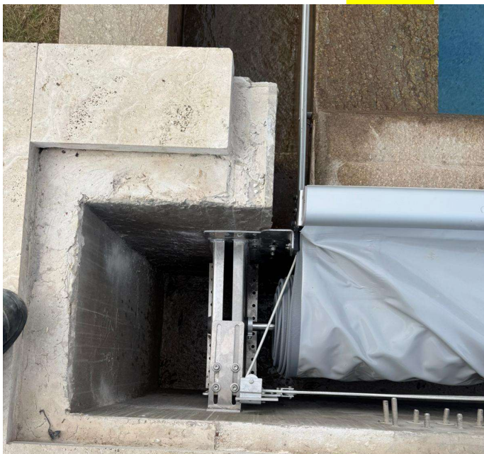
INSTALLAZIONE INFINITY SU LATO SINISTRO
